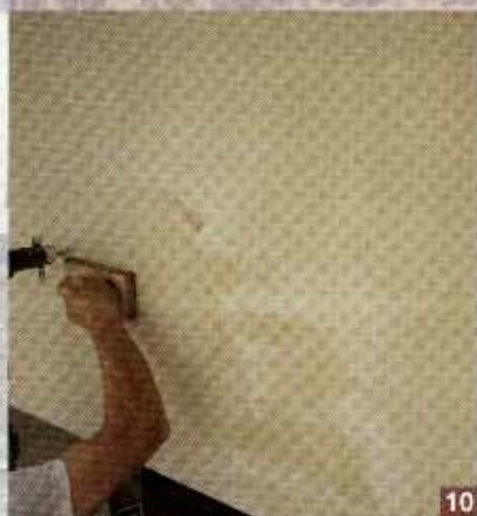
Foto 9 e 10. Dopo una prima stesura, per ottenere l'effetto "velato" Silancolor Pittura è stato successivamente applicato con un pennello sul supporto e immediatamente rifinito con un frottazzino di spugna.
