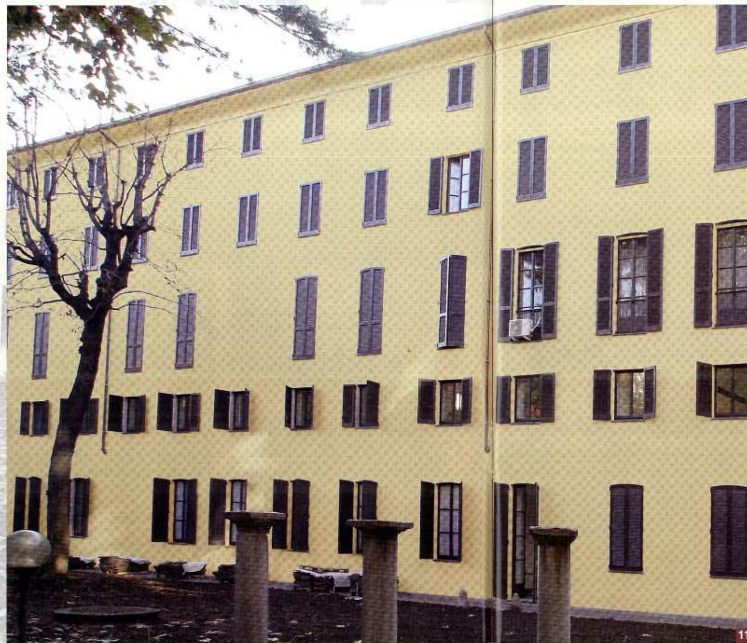
Foto 9 e 10. Dopo una prima stesura, per ottenere l'effetto "velato" Silancolor Pittura è stato successivamente applicato con un pennello sul supporto e immediatamente rifinito con un frottazzino di spugna.
