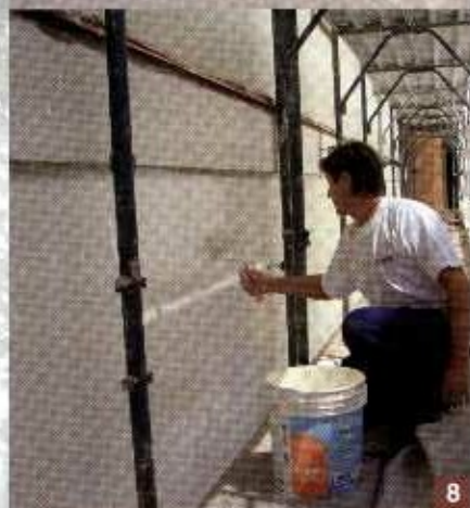
Foto 8. Per la finitura delle pareti è stato utilizzato Silancolor Pittura, applicato a rullo dopo la stesura di Silancolor Primer.
