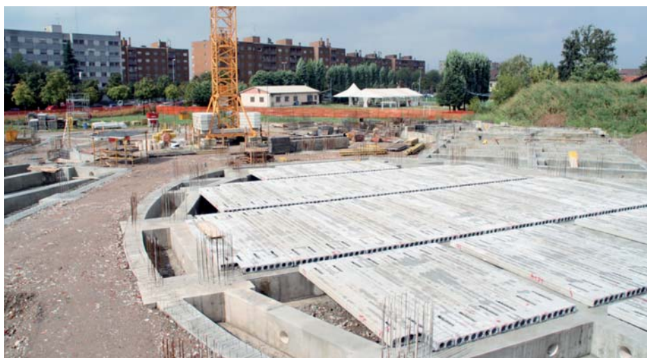
La struttura portante è composta da un sistema trilitico in calcestruzzo armato (1.992 m 3 , con 213 t di armature) e lastre prefabbricate tipo predalles e alveolari per le solette.
