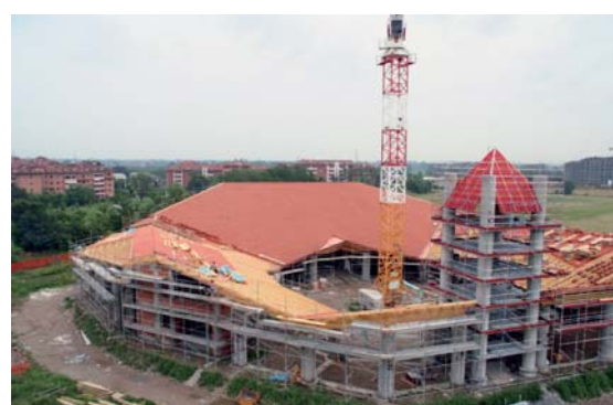
Nelle tre immagini sopra. Notevole la quantità di ponteggi impegnati – tutti di proprietà dell'impresa – per la realizzazione delle superfici in mattoni a vista e per la posa del manto in coppi.
