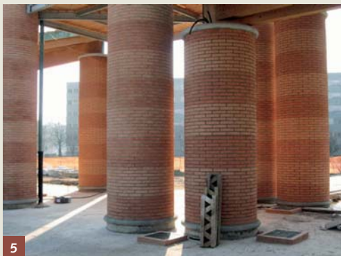
5-6. Per il manto di rivestimento delle colonne, SanMarco Terreal Italia ha prodotto pozzali appositamente disegnati e formati a mano, della stessa finitura e colore dei mattoni standard.
